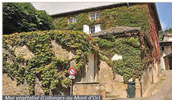
Mur végétalisé (Collonges-au-Mont-d'Or)
