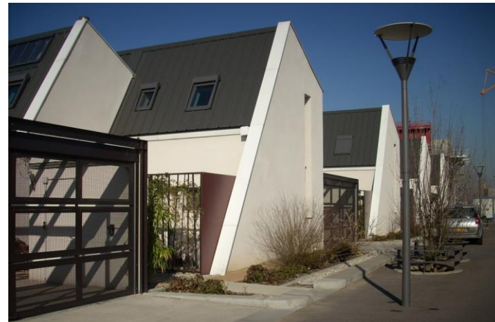
Logements de Haute Qualité Environnementale Hauts-de-Feuilly - Saint-Priest
