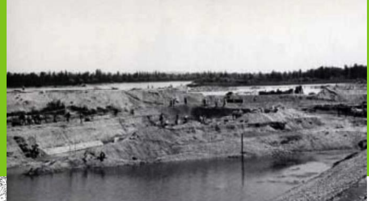
Construction du Canal:
